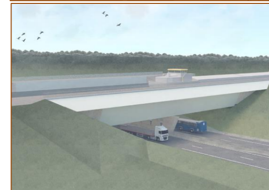
Franchissement en pont-canal : Autoroute A29
